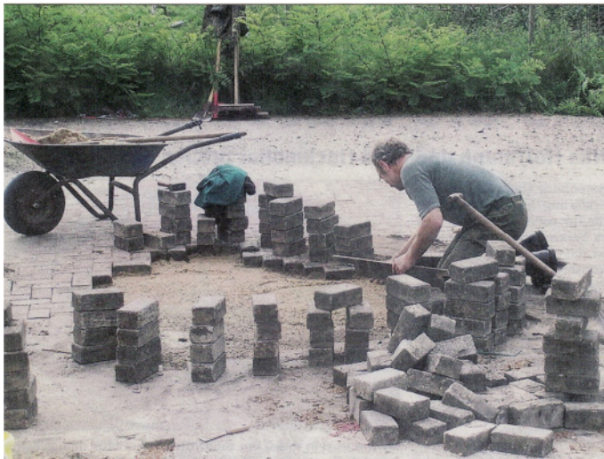
Das Setzen der Steine erfordert präzises Arbeiten
