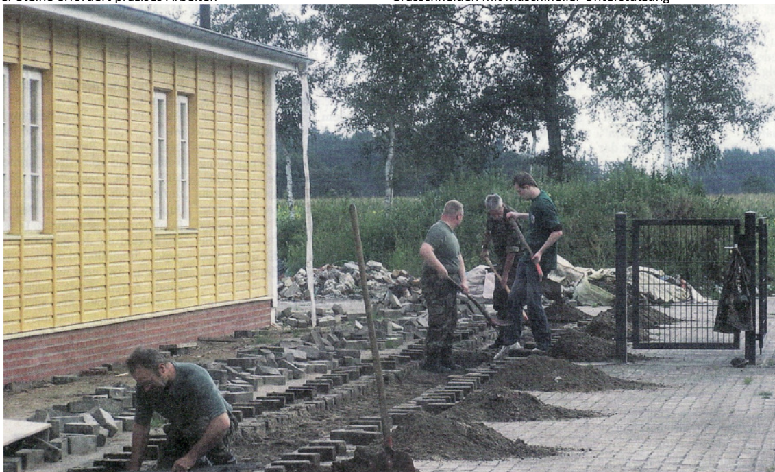
Umfangreiche Pflasterarbeiten wurden auf dem Gelände des ehemaligen Lagers Sandbostel durchgeführt.
